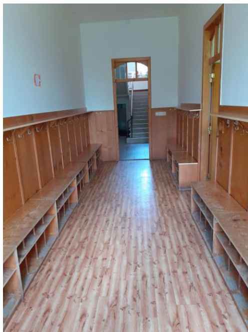
Levá šatna před rekonstrukcí.
